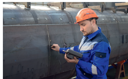
Контроль сварных швов ультразвуком
